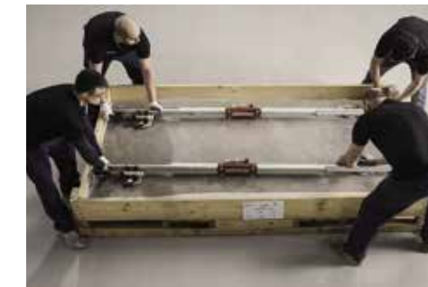
La movimentazione al piano può essere gestita con l'aiuto di un telaio provvisto di ventose per conferire una maggiore stabilità alla lastra.
