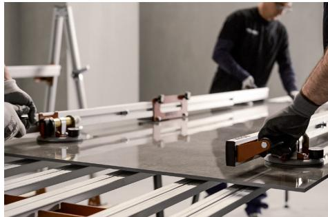
Si raccomanda di effettuare le operazioni di taglio sopra ad un piano perfettamente stabile e planare.
