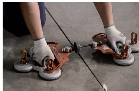
Per evitare che le lastre si scheggino durante la fase di posa si consiglia l'uso di un apposito dispositivo per l'accostamento delle lastre.
