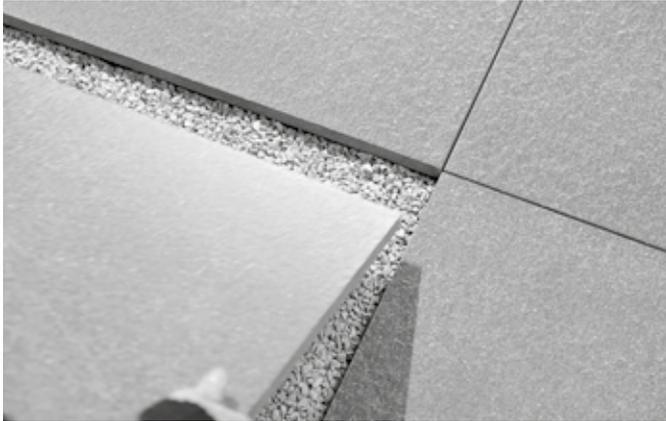
Die Trockenverlegung auf Kies wird für Anwendungen im Garten, Patio, Hof, für Fußwege und Terrassen empfohlen. Diese Verlegeart sorgt dafür, dass das Wasser unverändert durch die Fugen zwischen den Platten in das Erdreich sickern kann und somit ins Grundwasser abfließt. Diese Verlegelösung ist auch bei Eingriffen ideal, bei denen kein dauerhafter Fußboden verlegt werden kann.
