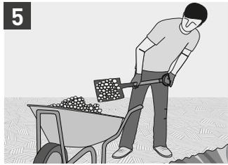
Eine je nach Art der vorgesehenen Belastung zwischen 20 cm und 30 cm dicke Schicht Kies mit 40-80 mm Körnung verteilen. Der Hauptzweck dieser Schicht besteht darin, den Belastungen zu widerstehen, die auf den Fußboden einwirken, indem sie als Trägerelement wirkt.
