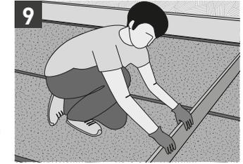
Je nach Einsatzbestimmung eine 10-30 cm dicke Kiesschicht verlegen, die über der Wabenmatte verbreitet wird. Um der Platte eine höhere Stabilität zu verleihen, wird Kies mit 3-6 mm Durchmesser empfohlen. Die Oberfläche mit zwei Schienen und einer Platte planieren. Um der Kiesschicht eine höhere Stabilität zu verleihen, kann man den Kies mit einer Betonmischmaschine mit 5% Zement und einer geringen Wassermenge vermischen.
