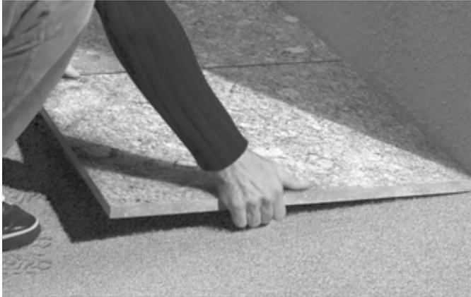
Das Verlegen auf Splitt wird für Anwendungen im Garten, Patio, Hof, für Fußwege und Terrassen empfohlen. Es handelt sich um eine vielseitige Verlegeart mit schnellen Umsetzungszeiten, dank derer der Fußboden je nach der gewählten Fugenart einfach entfernen kann.
