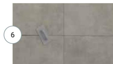
6 Sigillare le fughe con sigillante LITOKOL Fill Good o simili disponibili in una vasta gamma di colori, oltre ad effettuare delle zone di giunto con Ottoseal S70 o simili a seconda del progetto.
